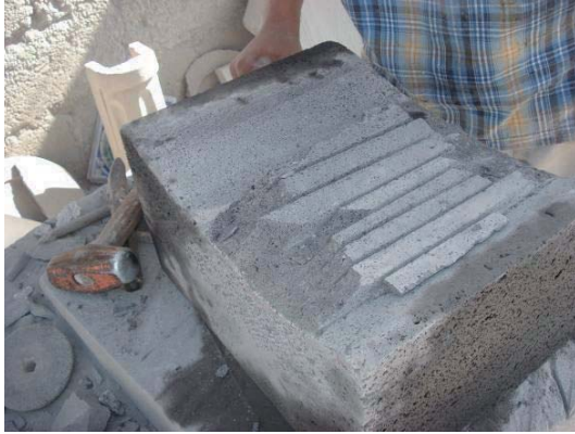
Figura 79. a) Observando donde intervenir. b) Desprendiendo con el cincel y martillo. Fuente: elaboración propia.
