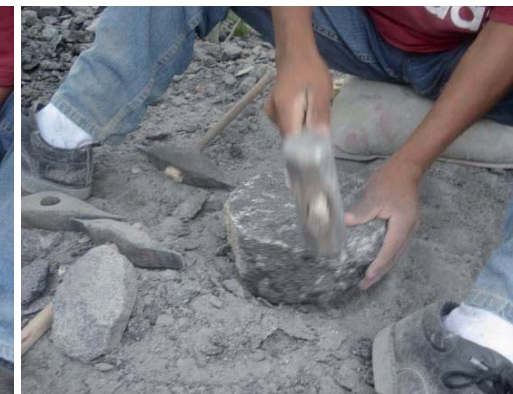
Figura 55. a) y b) Delineando la cara dorsal con el marro. Fuente: elaboración propia.
