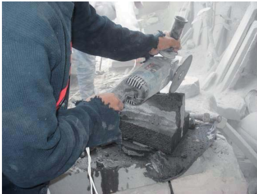
Figura 92. a) Corte interior del soporte. b) Desbaste de lo cortado. Fuente: elaboración propia.
