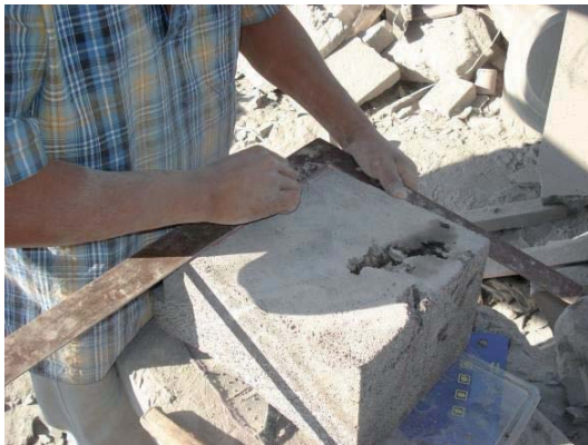
Figura 87. a) Trazando soporte cara ventral. b) Cortando sobre lo trazado. Fuente: elaboración propia.
