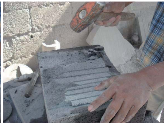
Figura 78. a) Emparejando con la cortadora eléctrica. b) Desprendiendo con el martillo. Fuente: elaboración propia.
