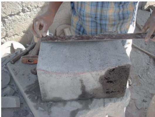
Figura 81. a) Comprobando las dimensiones. b) Verificando la superficie de molienda. Fuente: elaboración propia.
