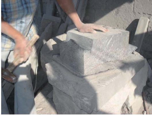
Figura 85. a) Desprendimiento con el martillo. b) Cortando de tanto en tanto. Fuente: elaboración propia.
