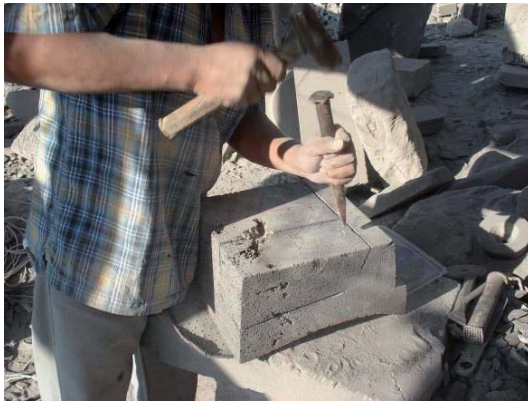
Figura 88. a) y b) Iniciando el desbaste posterior al corte. Fuente: elaboración propia.
