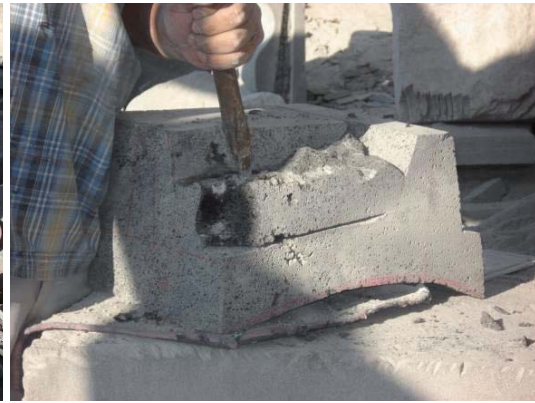
Figura 88. a) y b) Iniciando el desbaste posterior al corte. Fuente: elaboración propia.
