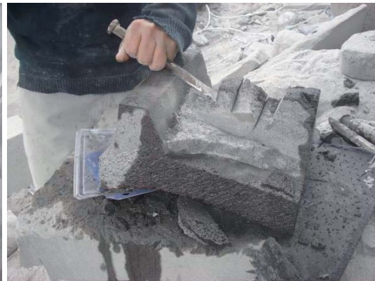
Figura 93. a) Corte interior de los soportes. b) Retirando lo cortado con cincel y martillo. Fuente: elaboración propia.
