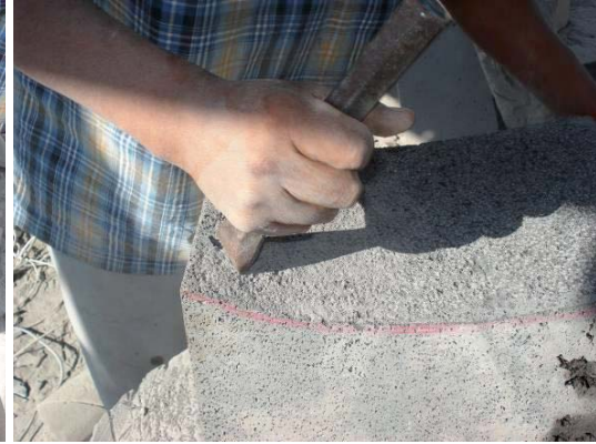
Figura 82. a) Delineando la superficie de molienda. b) Picando para dar textura. Fuente: elaboración propia.
