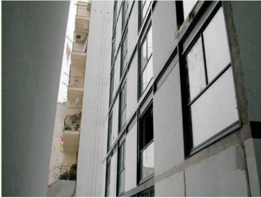
Vista del lateral de la façana interior de l'edifici a intervenir, a nivell mig.
