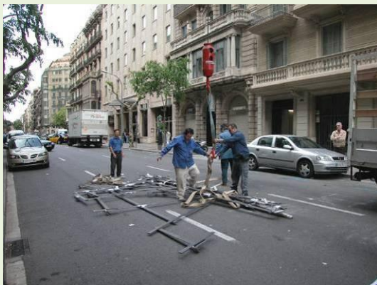
Pujada dels suports mitjançant grua cap a l'interior de l'edifici des del carrer Rosselló.
