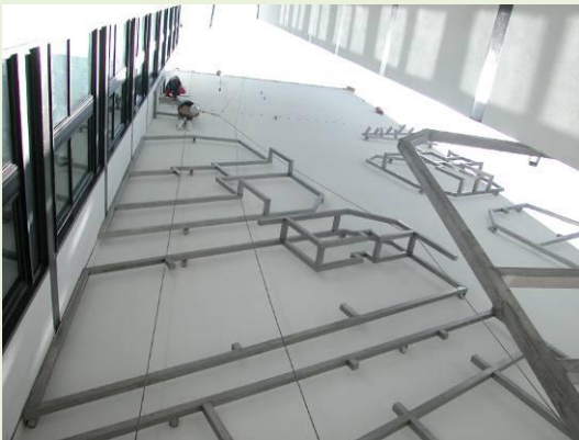
Muntatge de les peces per part dels operaris suspesos des de l'edifici veí.
