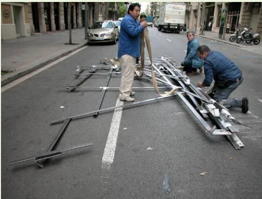
Pujada dels suports mitjançant grua cap a l'interior de l'edifici des del carrer Rosselló.
