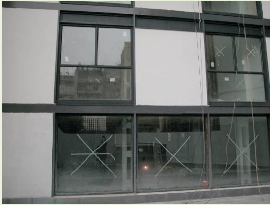
Detall façana interior. Es veuen les dimensions i la forma de cada un dels finestrals.
