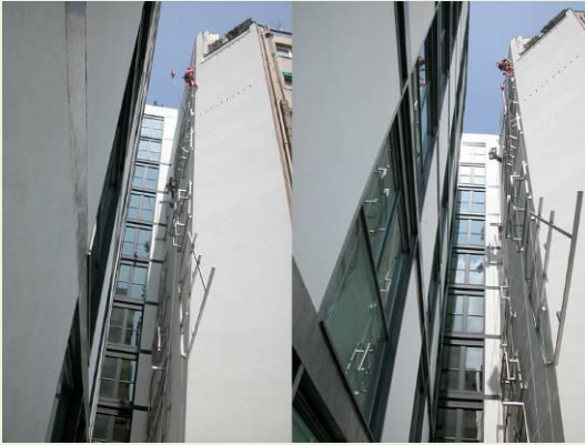
Muntatge de la última peça per part dels operaris suspesos des de l'edifici veí.
