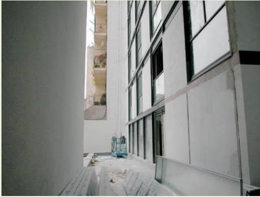
Vista del lateral de la façana interior de l'edifici a intervenir, a nivell de planta.
