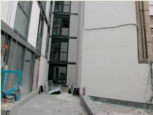
Pati interior nivell inferior.
