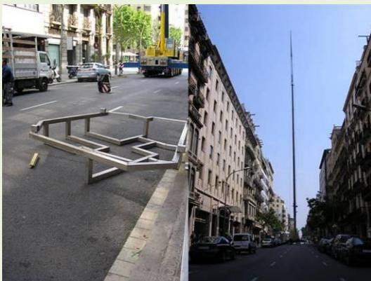
Distribució de les peces i vista de la grua.
