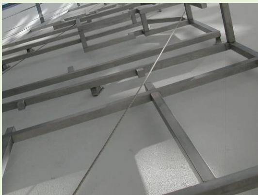
Muntatge de les peces per part dels operaris suspesos des de l'edifici veí.
