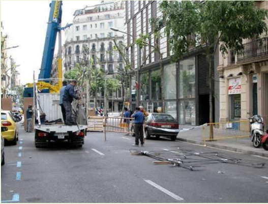
Distribució dels suports al carrer de Rosselló.
