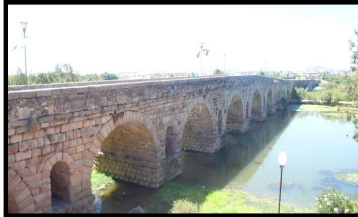
Figura 4: Pont de Mérida . FONT: Ferran Ribas.
