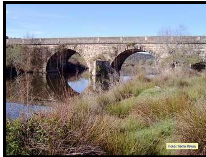
Figura 5: Pont de Cáparra . FONT: http://www.pueblos-espana.org .
