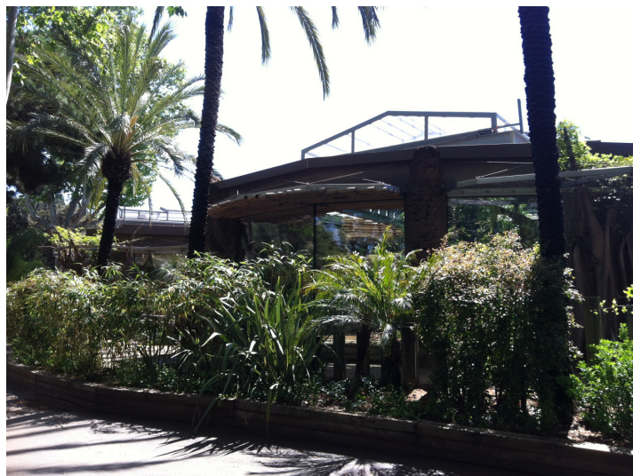
Vista des de fora de la instal·lació.
