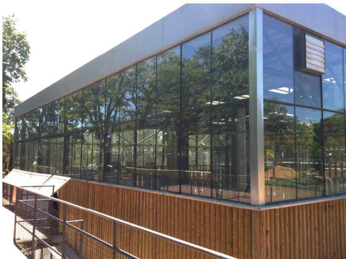
Els dormitoris des de l'exterior.
