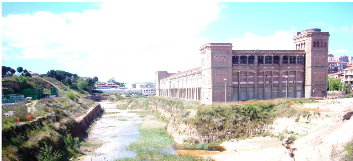
Foto 6.2. Estat actual de la parcel·la que ocupava la Fàbrica Nova. Font: pròpia.
