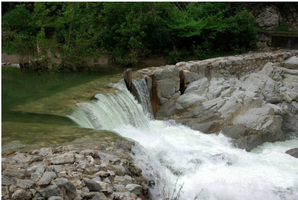
FIGURA 16. Resclosa amb pals de fusta clavats a la roca, al Llierca (Garrotxa)
