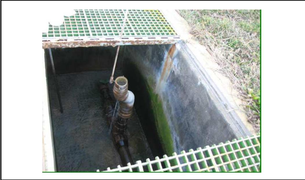
**Fotografía 3.7** Vista del depósito de salida con la tubería para controlar el nivel del agua dentro del humedal.
