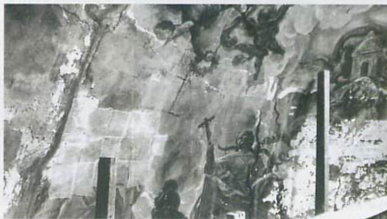
Fotografía de archivo donde se puede apreciar el estado de deterioro de los frescos en 1950. A la izquierda, proceso de engasado que se adoptó entonces como método de fijación de los desprendimientos en la cúpula central.
