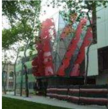
14. Edifici departamental Universitat Pompeu Fabra
