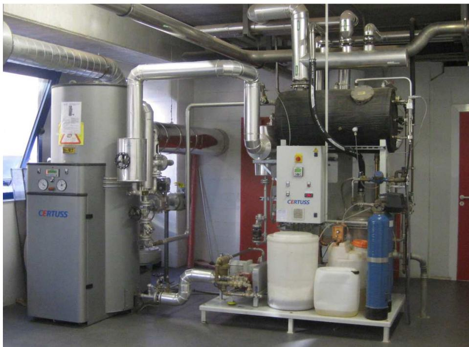
***Equipo caldera, descalsificador, depósito de agua tratada y condensados.***
