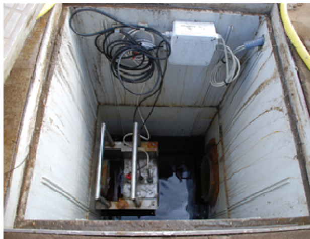
Figura 5. Bombes de recollida de lixiviats amb sondes de pH, conductivitat i temperatura.
