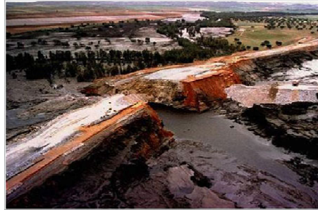
Figura 16. Mur de contenció de la mina d'Aznalcóllar trencat [85].
