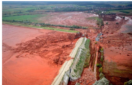
Figura 19. Presa trencada de la mina d'Ajka [85].
