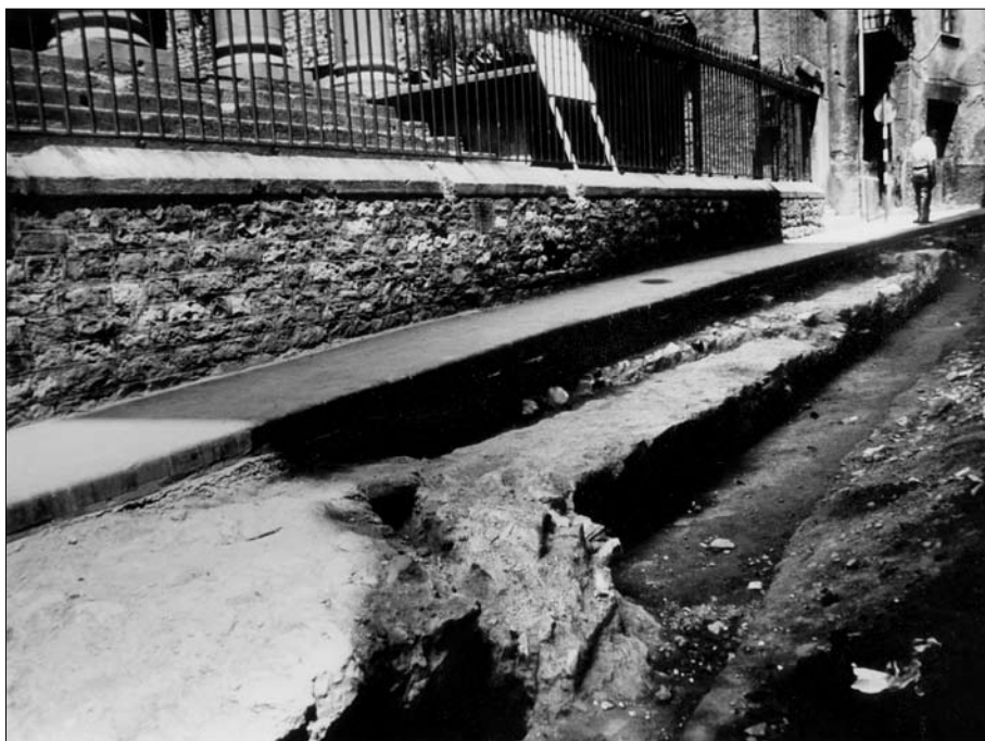
Descobriment dels fonaments del mur frontal del períbol del temple romà. Fotografia Ajuntament de Vic.
