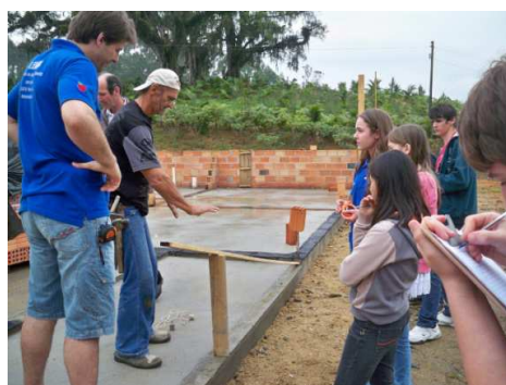
Figura 3 - Pedreiro explicando a construção do telhado
