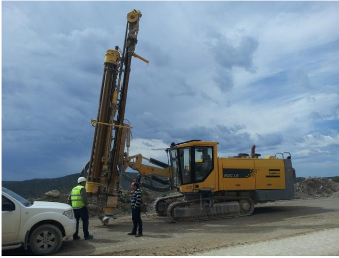
Figura 8: Màquina perforadora, a l'exploració "Les Cubetes"
