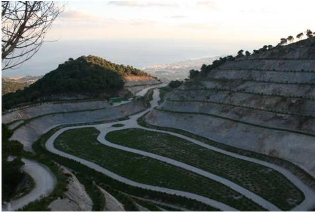
Figura 38 : Exemple de restauració ecològica de la pedrera de Mijas (Màlaga)
