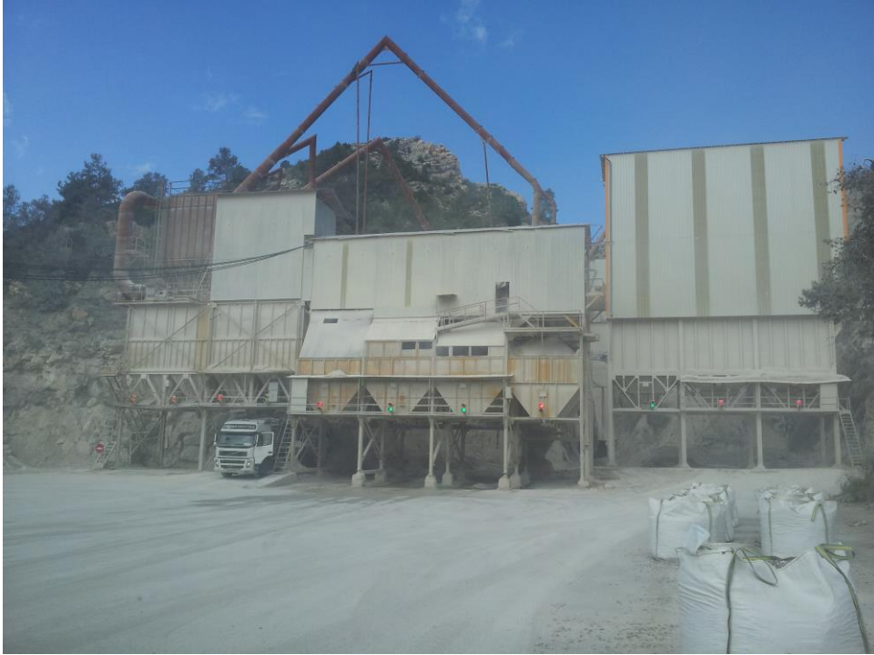
Figura 12: Estació de distribució de material fi a camions.
