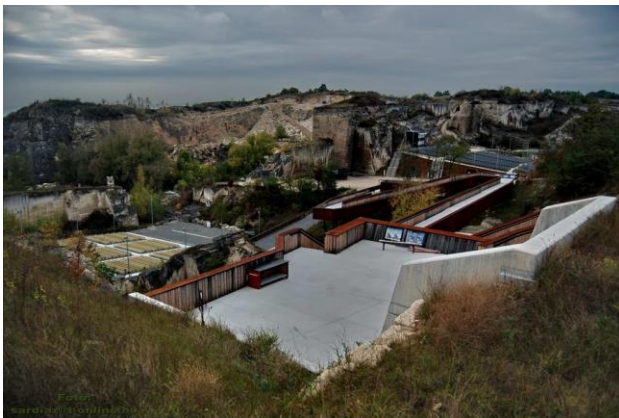
Figura 39: Antiga pedrera reaprofitada com a teatre a Burgenland, Àustria i museu-pedrera de s'Hostal, Menorca
