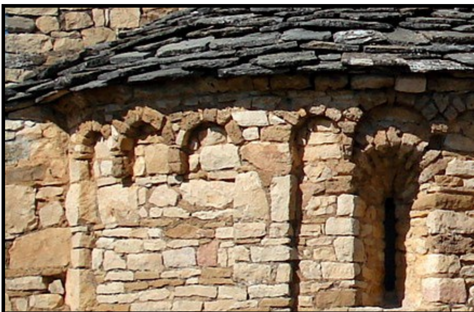
Figura núm. 28: detall de la bateria de nínxols sota el ràfec de la teulada de l'absis principal (foto: Jordi Garrober).
