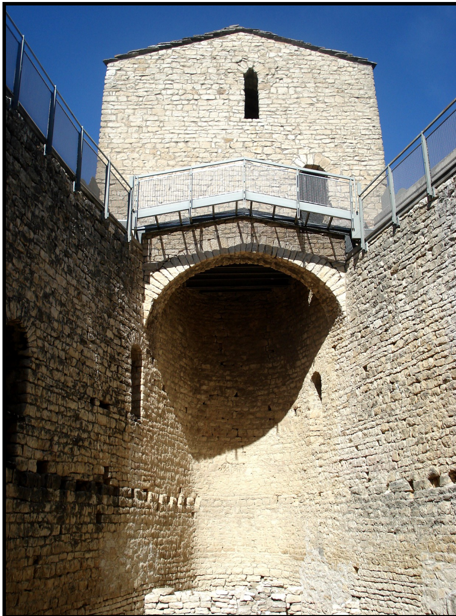
Figura núm. 15: vista general de l'espai on es trobava la sala noble del castell de Mur. A la part superior es bastí un arc de pedra damunt del qual reposa la bestorre, accessible des del sostre del domicilium i/o des del pas de ronda (foto: Jordi Garrober).
