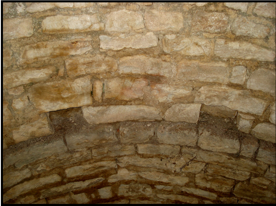
Figura núm. 6: fotografia d'un dels relleixos de l'interior de la torre mestra, d'uns 5 cm d'amplada, suficient per a col·locar-hi els caps de bigues que anirien introduïts en els forats que veiem en la imatge (foto: Jordi Garrober).
