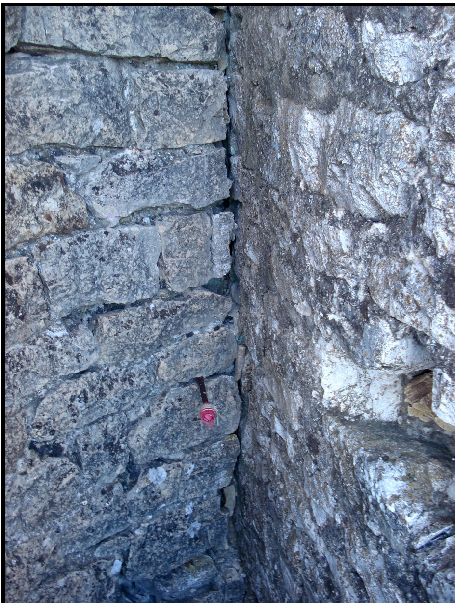
Figura núm. 8: fotografia del punt d'unió entre la torre mestra (dreta) i el pany de muralla (esquerra), elements adossats però sense estar travats constructivament (foto: Jordi Garrober).
