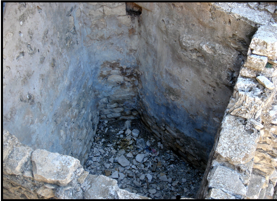
Figura núm. 16: fotografia de l'interior de la cisterna del castell, encaixada entre la torre mestra (mur arrodonit) i la paret del recinte (mur de l'esquerra) (foto: Jordi Garrober).
