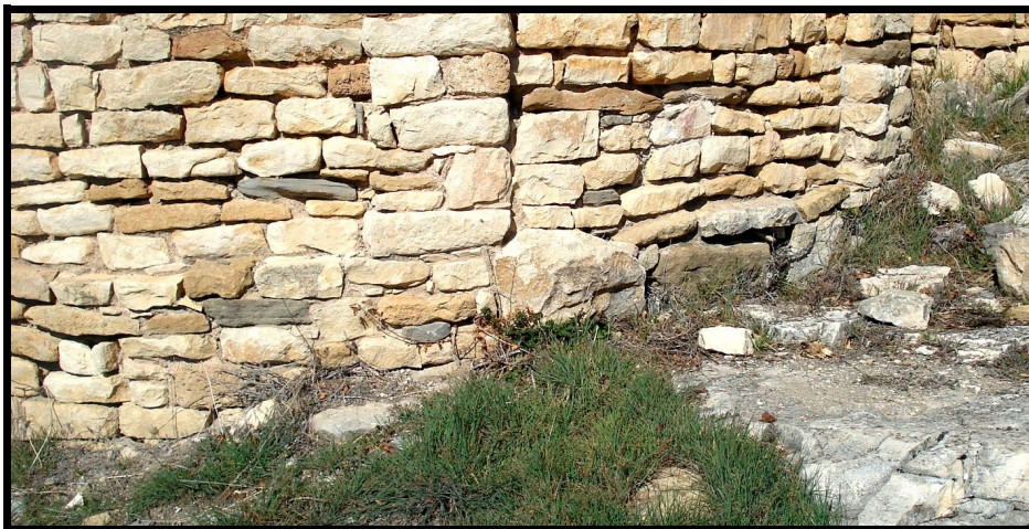
Figura núm. 27: vista dels fonaments de l'absis meridional de l'església, on podem observar els fonaments artificials de l'edifici allà on la roca mare queda desnivellada (foto: Jordi Garrober).
