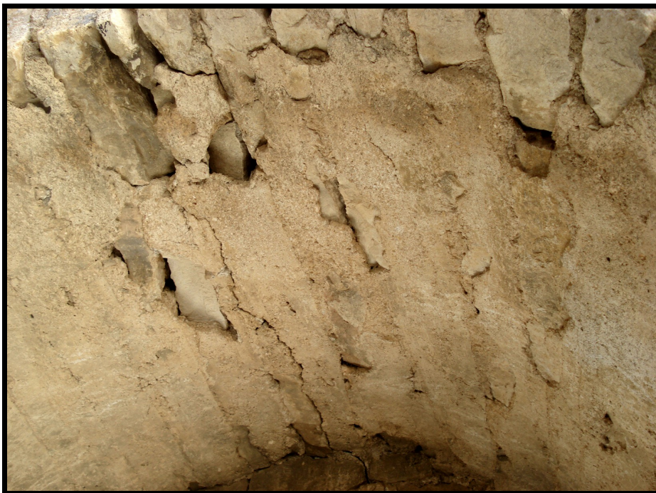
Figura núm. 17: fotografia de l'arc de la porta realitzada des de l'interior del castell. Hom pot observar-hi les restes de morter de calç introduïdes durant el bastiment de l'arc (foto: Jordi Garrober).
