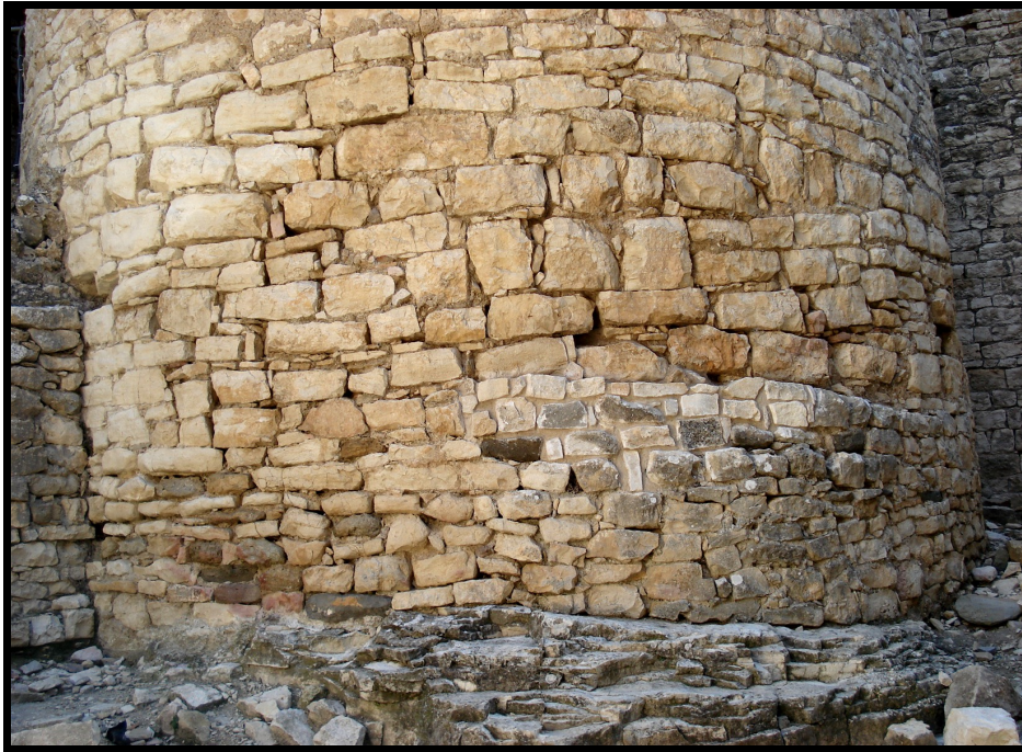
Figura núm. 9: vista de la base de la torre mestra de Mur, realitzada a partir d'un aparell de peces generalment grosses, poc tallades i sense formar filades regulars (foto: Jordi Garrober).
