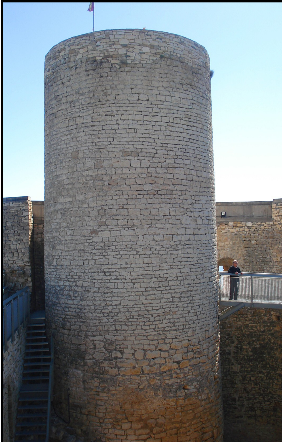
Figura núm. 5: vista de la torre mestra de Mur des del vessant nord-oest de l'interior del castell. En la imatge hom pot observar les diferències entre el parament arquitectònic de la part inferior, de carreus grans i poc escairats, i el superior, de carreus més petits, plans i ben tallats (foto: Jordi Garrober).
