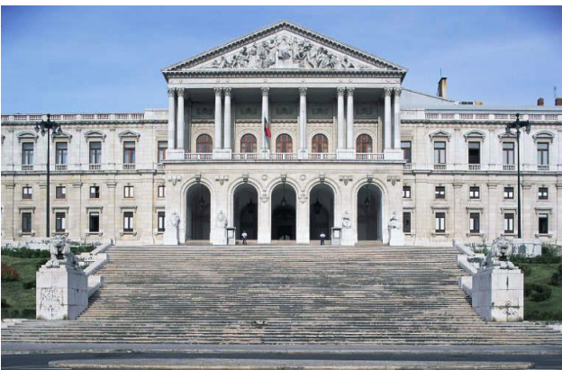
Cristino da Silva i Ventura Tierra, Escalinata i façana principal, 1941.
