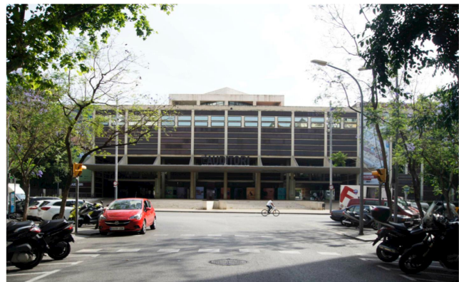
Fig. 29 L’Auditori 1999. Fuente: fotografía propia del autor.
