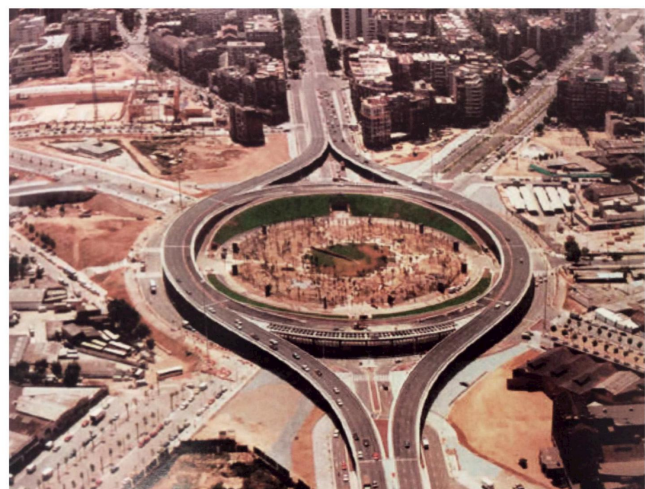
Fig. 27 Tambor vial construido en Glorias para las olimpiadas de 1992. Fuente: Rui-Wamba, J. Guerrero, S. La plaza de las Glorias Catalanas. 2009.
