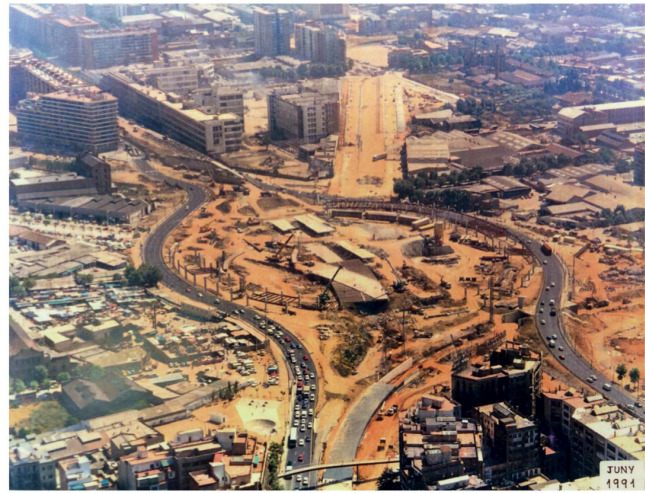
Fig. 25 Vista de la construcción de los túneles ferroviarios que atraviesan por debajo de la plaza 1991. Fuente: Rui-Wamba, J. Guerrero, S. La plaza de las Glorias Catalanas. 2009.
