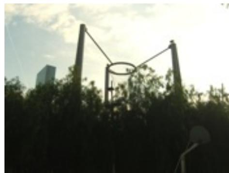
Esistono altri due pozzi: il pozzo d'acqua, ovvero un cilindro di acciaio inossidabile di 9 metri d'altezza sospeso verticalmente in tre pali di 15 metri d'altezza (Fig. 3.27) e il pozzo disco, un anello con sezione trasversale a forma di U utilizzato per sistemarci la terra vegetale e servire come vaso sospeso a 2,5 metri d'altezza.
