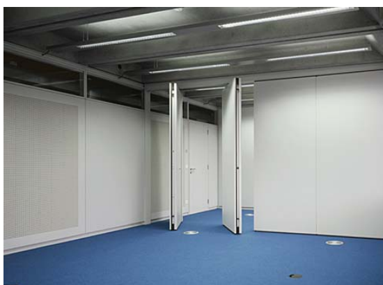
Fig. 98> Envà mòbil monodireccional. Fabricant Espero. Imatge cedida per Espero a Muros Moviles Acusticos TST. Esquema il·lustrat d'un envà mòbil monodireccional.
