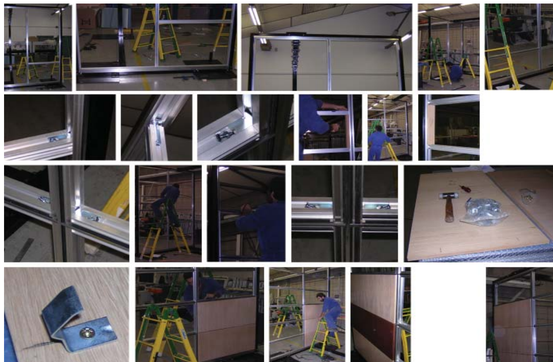
Fig. 96> Procés de muntatge Bal 82. Instal·lacions del Bruc. Sistemes Bal S.A. 2009
