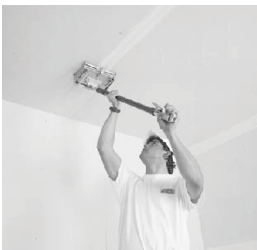
Fig. 69> Procés d'encintat. "Pladur"
