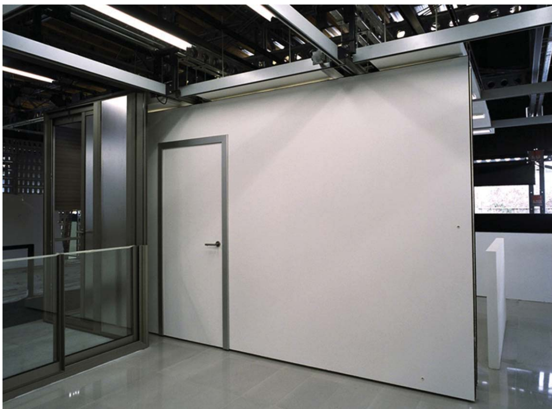
Fig. 11> Instal·lació del TST-Home a casa Barcelona. 2007
