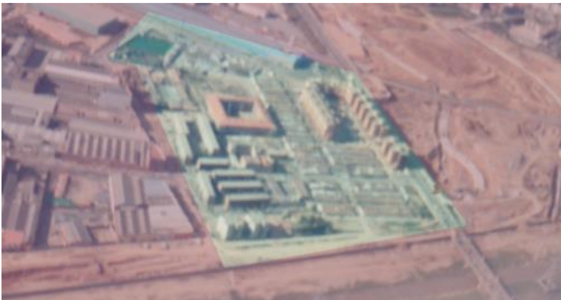
Fig.248>Fotografia aèria on es poden apreciar la resta de les cases barates i polígons i una part edificada del "gran salón". A la dreta de la imatge els solaris encara buits on s'acabarà construint el Nus de la Trinitat i les infraestructures associades a les rondes. Font: aportació IVes Jornades Participatives BdV
