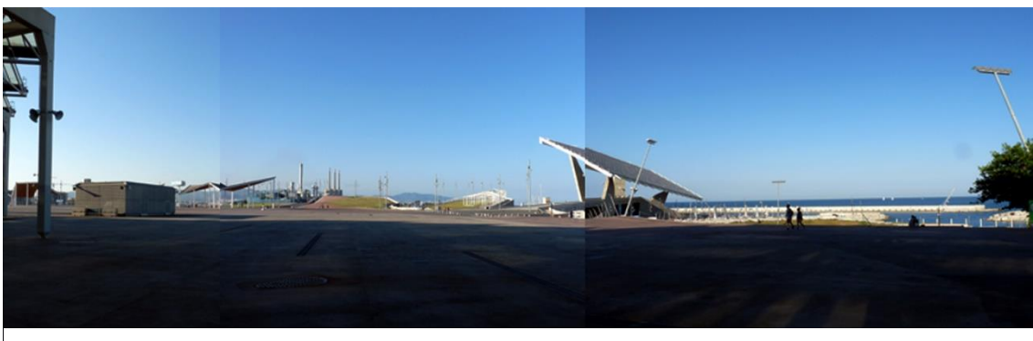
Fig.136>Espai principal de l'espai Fòrum amb la placa fotovoltaica dominant el paisatge .Font: de l'autor
