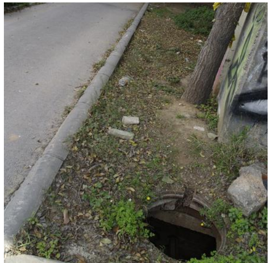
Fig. 257,258,259,260>El pas per sota del pont de Santa Coloma mostra greus problemes de seguretat: sense il·luminació, infraestructures elèctriques sense controlar i un accés al clavegueram sense la tapa de registre. L'AVV ha comunicat aquestes problemàtiques als responsables del Districte de Sant Andreu en diferents ocasions. Font: de l'autor.
