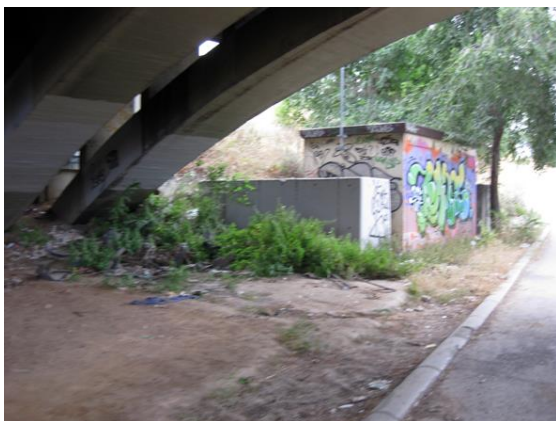
Fig. 257,258,259,260>El pas per sota del pont de Santa Coloma mostra greus problemes de seguretat: sense il·luminació, infraestructures elèctriques sense controlar i un accés al clavegueram sense la tapa de registre. L'AVV ha comunicat aquestes problemàtiques als responsables del Districte de Sant Andreu en diferents ocasions. Font: de l'autor.
