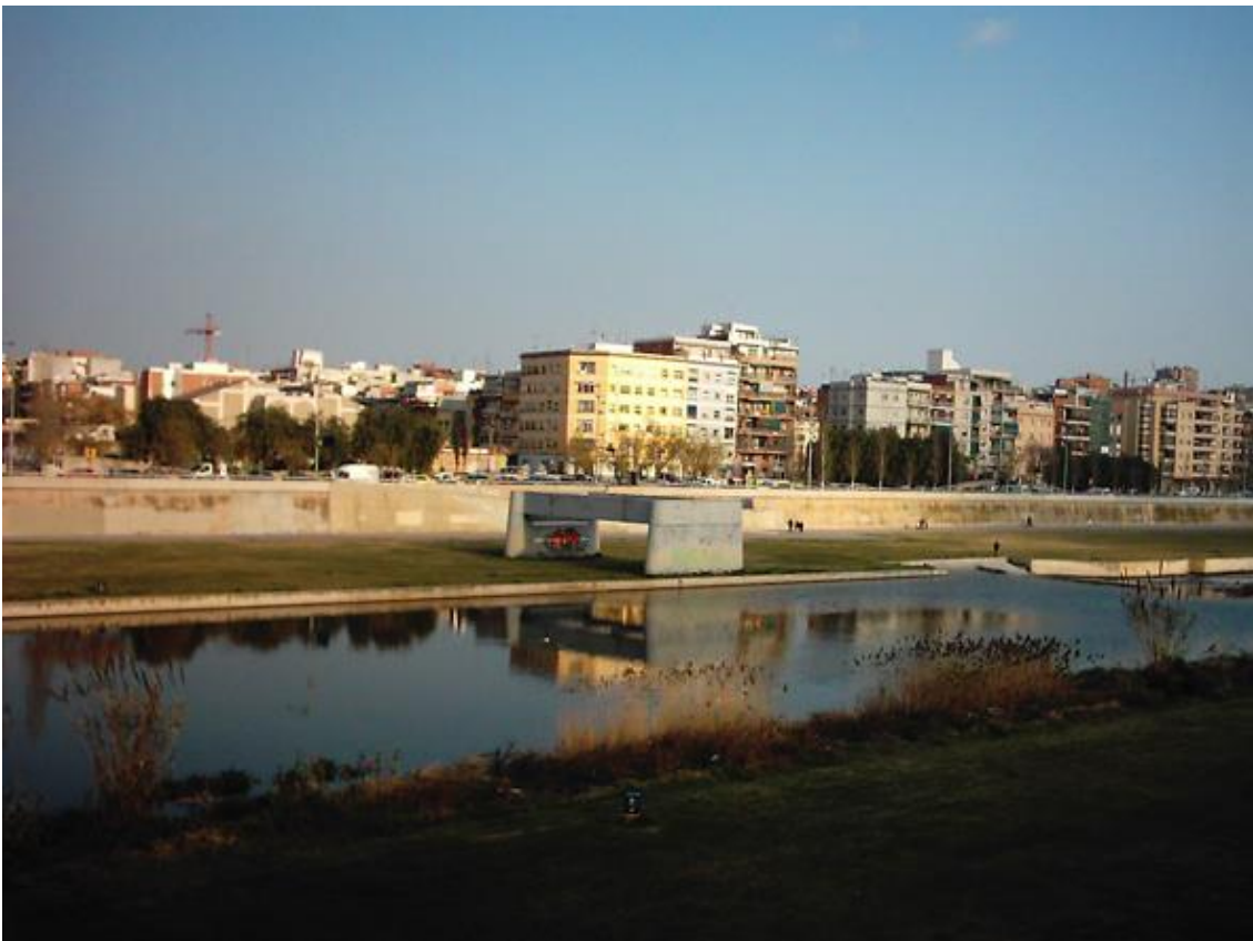
Fig.262>Base de la torre elèctrica que resta en el riu com a un hipotètic element de memòria històrica. Font: de l'autor.
