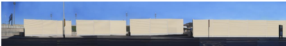
Fig.374>Segment inicial de la pantalla acústica, abans de l'intervenció artística. El tres primers plafons tenen allunyaments i cotes diferents, la resta és contínua fins a l'entrada on es troba la bocana del metro de Baró de Viver. Font:CRPolis
