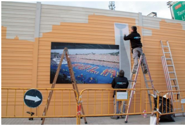
Fig.469,470,471> Diferents moments del procés d'execució. Font: CRPolis
