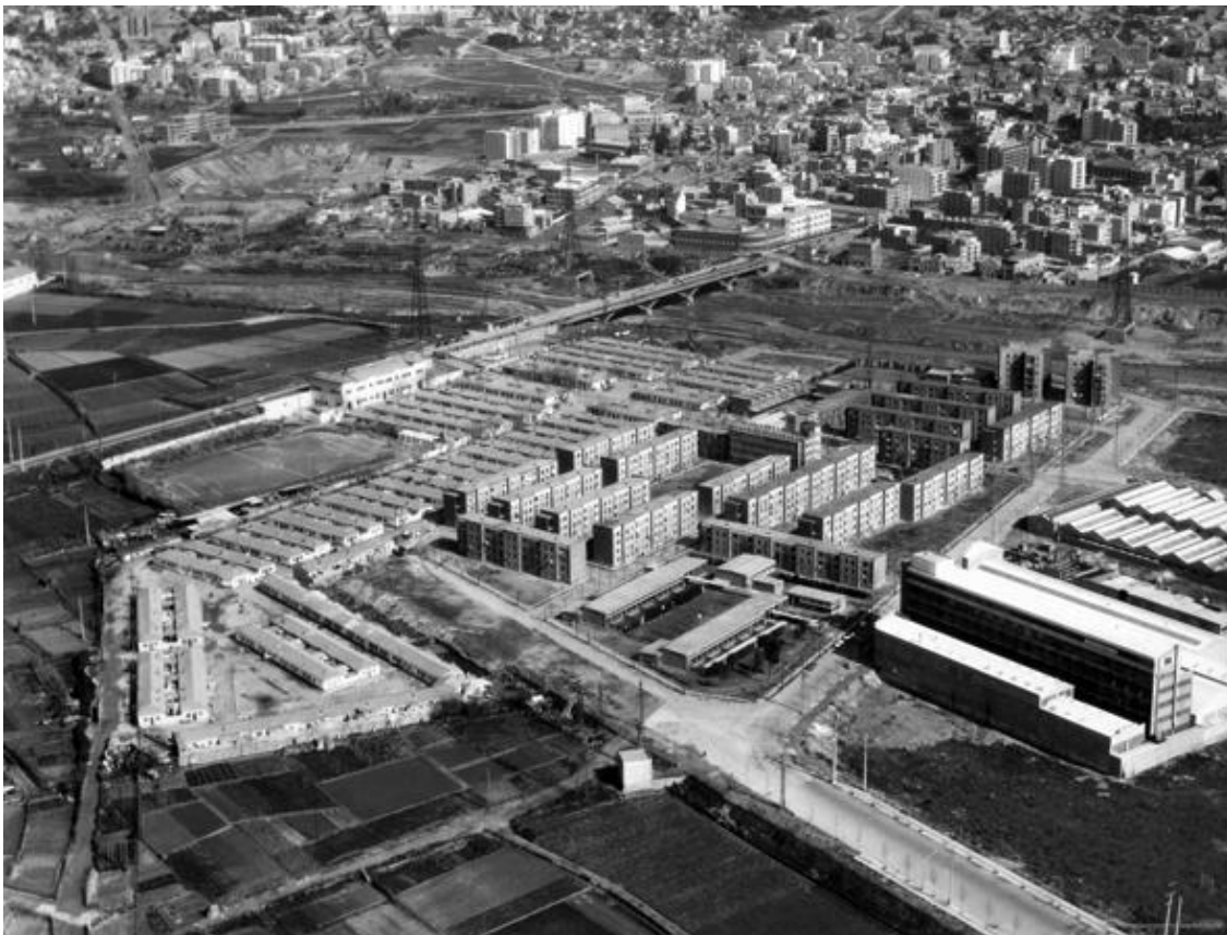
Fig.241>Baró de Viver 1960. Foto aèria que es pot apreciar la coexistència del barri del 1929 i les noves vivendes de 1958. Font:Imatge del Patronat Municipal de l'Habitatge de Barcelona
