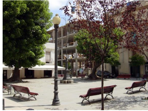
Fig.159>La Plaça Prim amb dels nous blocs de pisos en construcció. Font: de l'autor.
