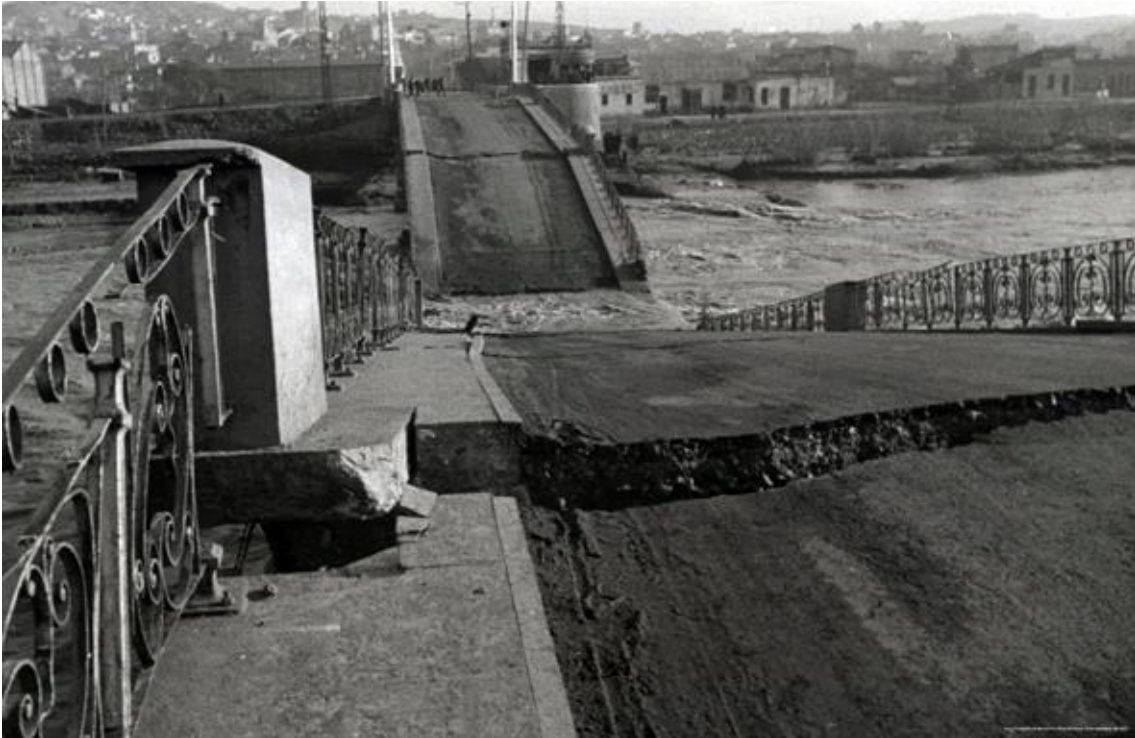
Fig.243>La riada del 1943 va destruir el pont de Santa Coloma. Font: Arxiu fotogràfic de Barcelona
