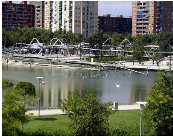
Fig.128>El llac central del Parc Diagonal Mar. Font: de l'autor
