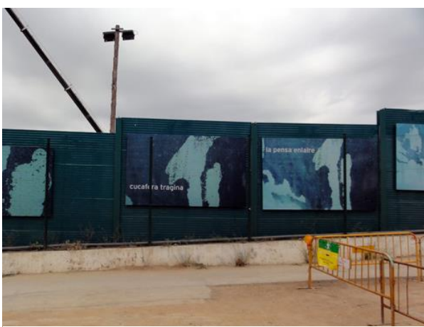
Fig.414>Tanques de protecció de les obres de la Línia 9 de metro/ Zona Universitària .Font: CRPolis
