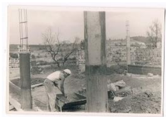
Construcció del Centre Cultural de Marata
