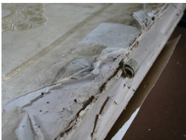
Pèrdua de material de la coberta.
