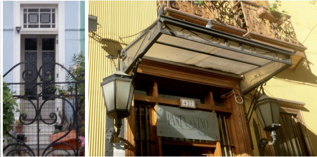
Fig. 74. Algunos despropósitos de la modernización dentro de un ámbito patrimonial :Se eliminaron las cornisas, aspecto ornamental distintivo en la línea de construcción del barrio; la puerta metálica en forja artesanal. En el sistema industrial las formas orgánicas son conseguidas mediante placas en fundición gris; la marquesina está construida con perfilería y soldadura al arco y no corresponde a las posibilidades técnicas de la época.
