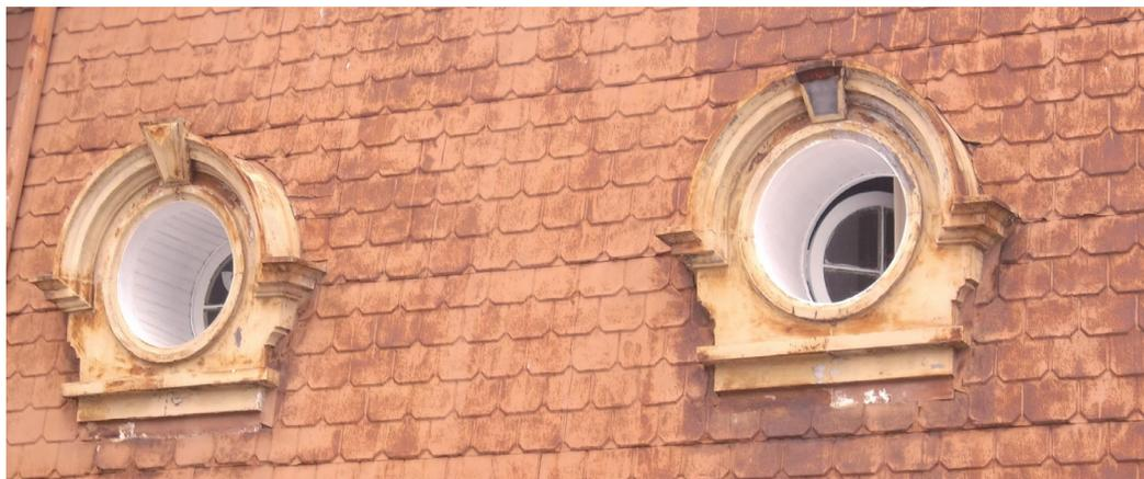
Fig. 42. Elementos de lata estampada de factura industrial, para ornamentación de fachadas
