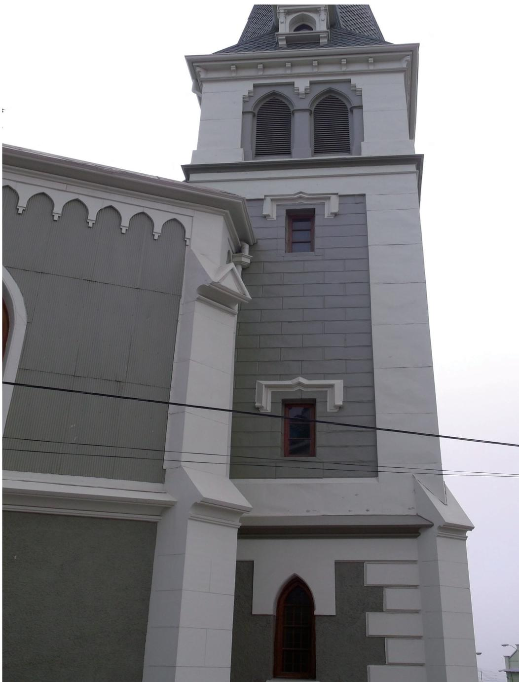
Fig. 44. La torre de la Iglesia Luterana de la Santa Cruz del cerro Concepción, que fuera reconstruida luego de ser afectada por el terremoto de 1906, presenta hoy revestimientos de lata a partir del segundo nivel.
