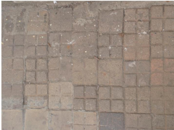
Fig. 42. Pavimento en base a palmetas de arcilla cocida encontradas en una acera del Pasaje Gálvez. Fotografía tomada el año 2011. Este tipo de pavimento también aparece en fotografías antiguas de otros cerros (el verdulero, tomada en 1904, al parecer en el cerro Florida). Fuente: propia / *El mercurio*. Valparaíso 1900.
