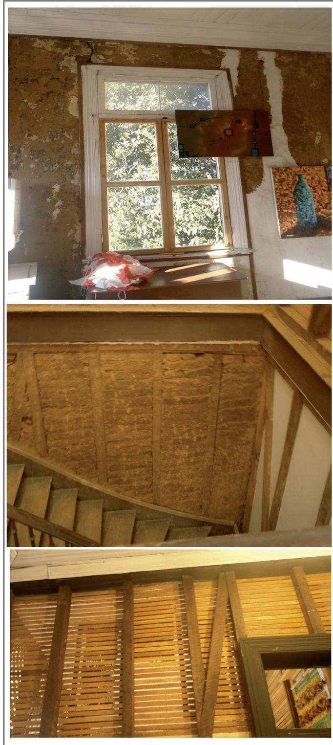
Fig. 41. El sistema constructivo al descubierto en un edificio en vía de transformarse en local comercial
