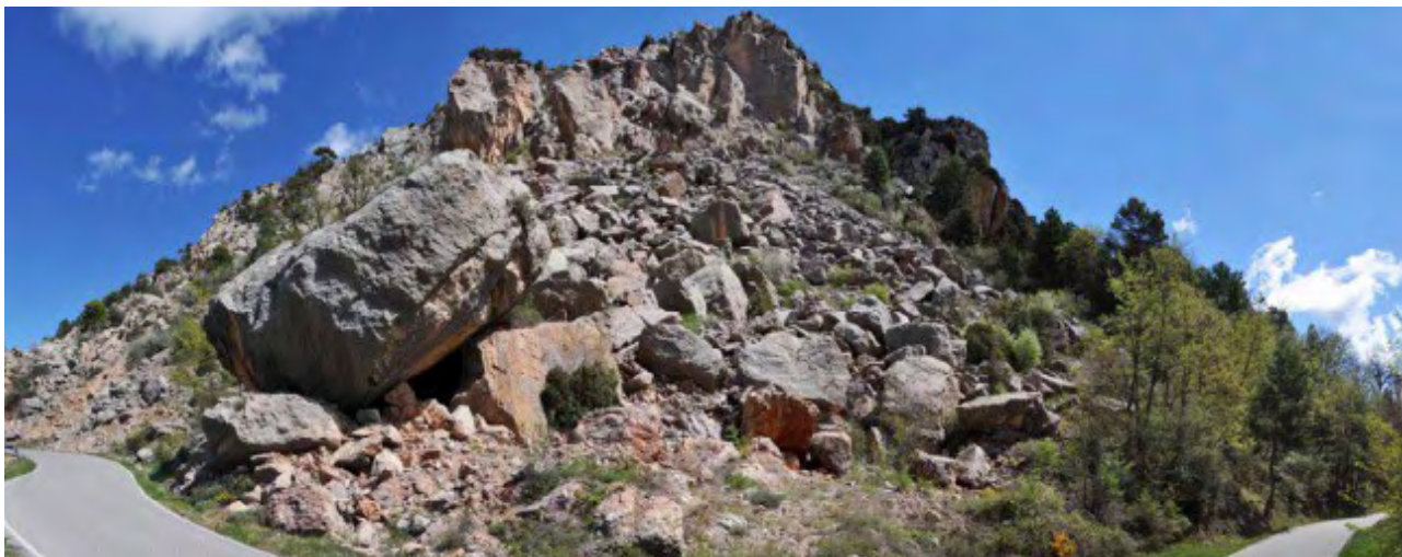
Figura 20: panoràmica de l'esllavissament des de la carretera L-401.
