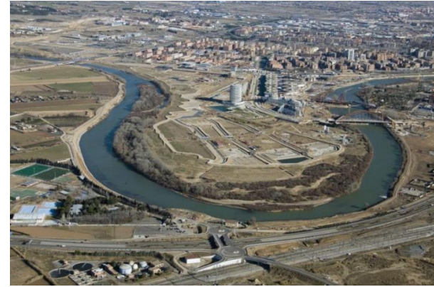
Construcción de la Expo 2008. Fuente: Proyecto Expo Zaragoza 2008
