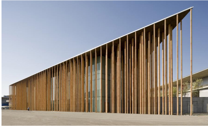
Edificio donde se ubicará el Museo PACUA. Fuente: Fotografía propia
