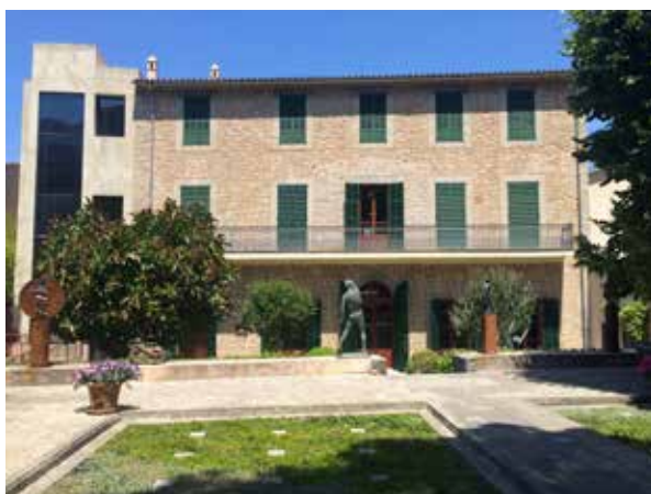
Foto 13. Façana pati interior.
