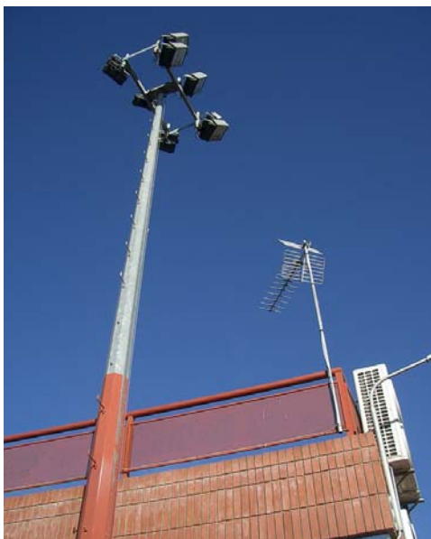
Figura 2.20.- Detalle de las instalaciones
