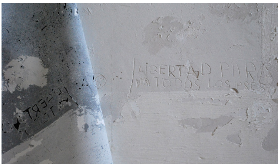
P. Gómez i M a J. González, detall de la intervenció.
