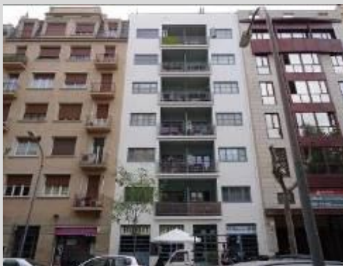
1928-1929. J.L. Sert. Edificio Viendas. C/Rosselló, 36
