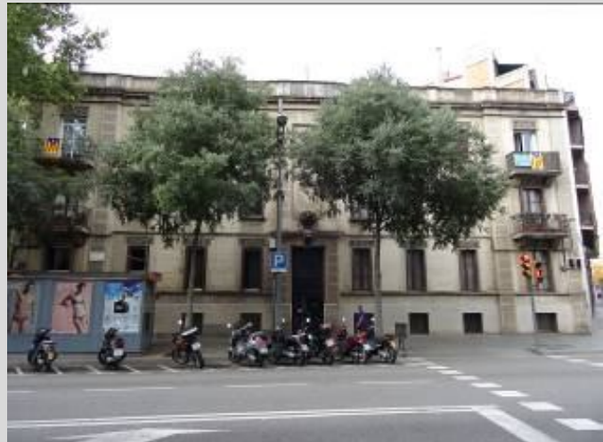
1918. Casas baratas en bloque, Passeig Maragall, 391
