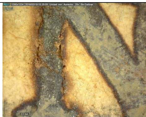
Corrosió de tintes metal·loàcides del teixell
