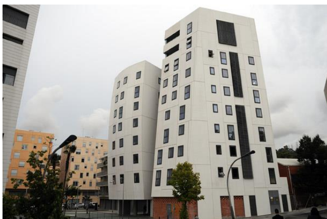
Els habitatges es troben a l'edifici Eucaliptus, al barri de Torre Baró, del districte de Nou Barris.
