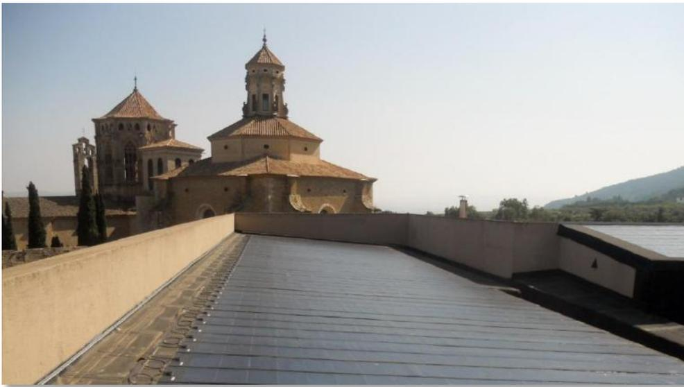
**Imagen 16. Celdas fotovoltaicas de última generación en el techo del Palau Nou de l'Abad**
