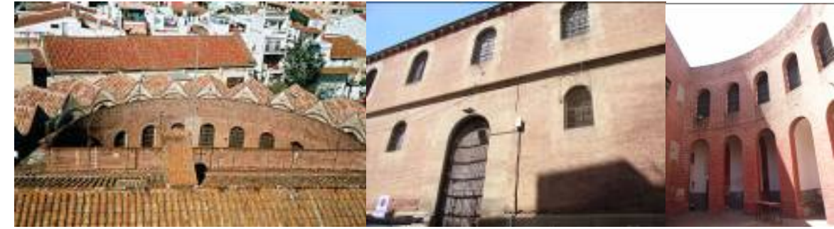
Imatges de la teulada, façana i pati de l'edifici de la presó de Mataró
