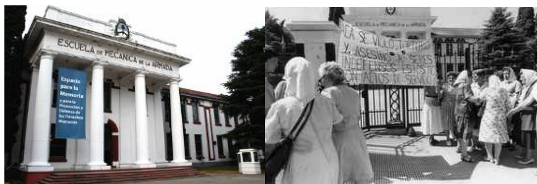
Façana de l'edifici de l'ESMA
