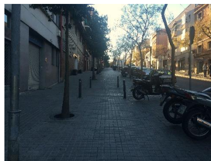
Ilustración 179. Aceras amplias con mobiliario urbano. Fuente: Fotografía propia de la autora. 2015
