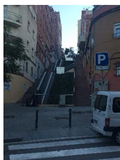
Ilustración 184. Tramos de escaleras mecánicas. Aparcamientos exclusivos. Fuente: Fotografía propia de la autora. 2015
