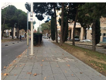
Ilustración 165. Pavimento Podo-táctil en parada de bus. Fuente: Fotografía propia de la autora. 2015
