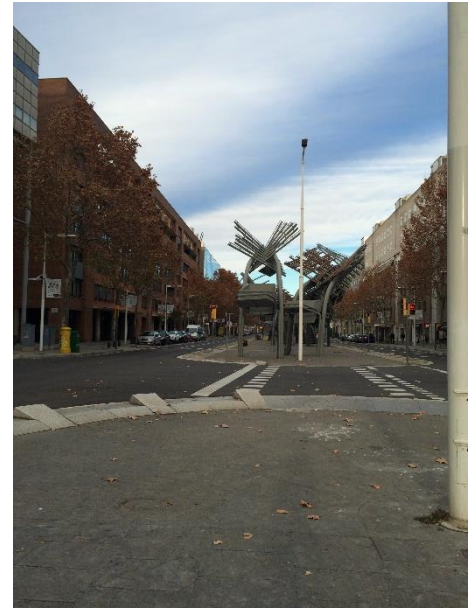
Ilustración 158. Paseo central con pendientes. Fuente: Fotografía propia de la autora. 2015
