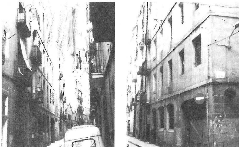
Dues perspectives de la casa-fàbrica del carrer de la Riereta número 10. Les finestres quadrades i regulars indiquen el que havien estat els tallers. A l'extrem de la fàbrica hi ha els habitatges, caracteritzats pels balcons.
