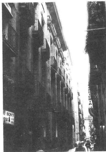
Façana neoclàssica i senyorivola de la Manufactura Magarola, al carrer de Tallers. Aquesta antiga fàbrica utilitzaria posteriorment el vapor.
