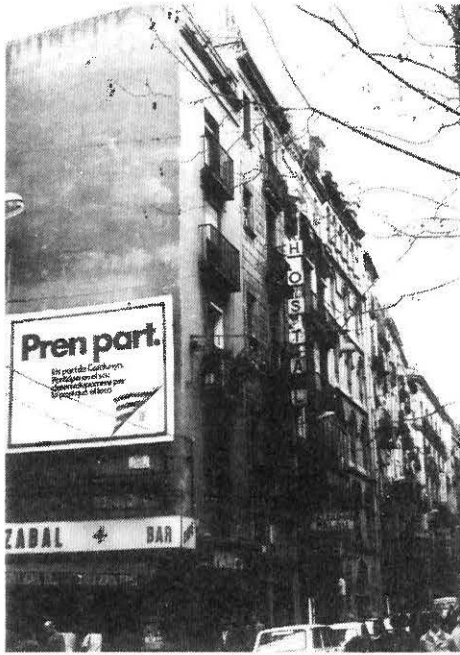
Casa del segle XVIII a la cruïlla dels carrers de l'Hospital i de la Junta de Comerç.
