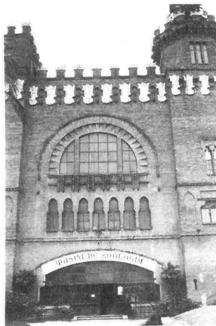
Detall del treball amb maó com a incorporació de la policromia en l'arquitectura. L'interès per la botànica es reflecteix en els plafons de ceràmica que coronen la part superior.
