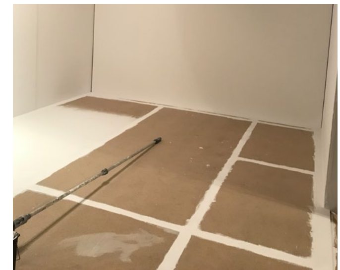
(Fig. 21) Elaboració pròpia, detall del procés de construcció de la tarima, 2022.
