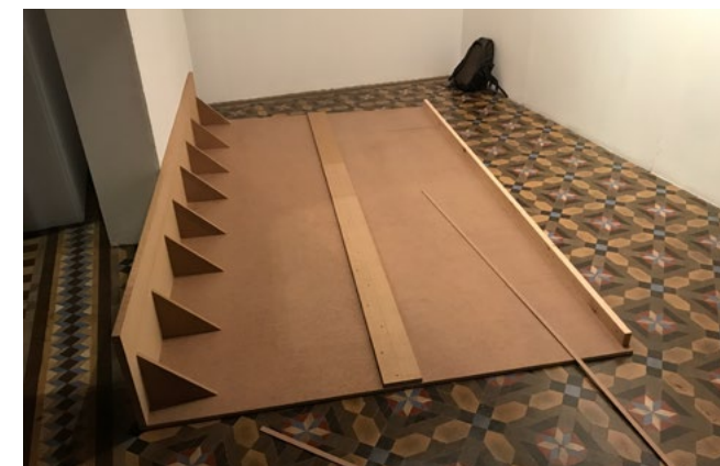
(Fig. 19) Elaboració pròpia, estructura del mur construït, 2022.
