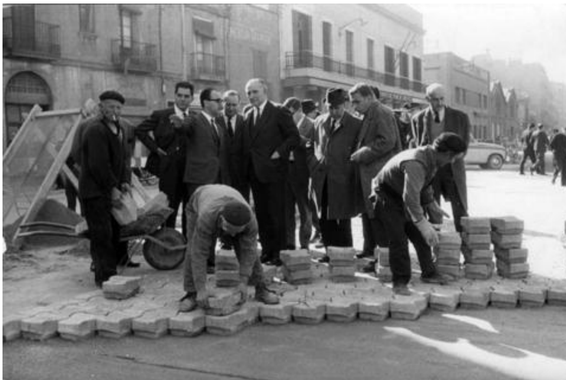
54 - J. M. Porcioles visita obras de pavimentación de La calle Pere IV (1966).
