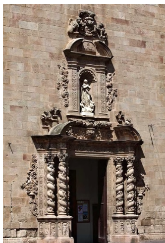
Fig. 13. Detall de la façana de l'església parroquial de Caldes de Montbui.
