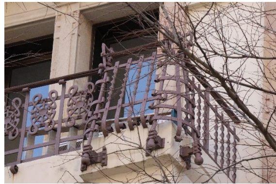
Imatge 22 (Foto IBN). Casa Bartomeu Recolons, Girona 1-Rda. St. Pere 39. Projecte signat per Miquel Pascual i Tintorer, 1891. La decoració metàl·lica, de forja amb elements de fosa, ens remet a la que Berenguer Va fer pel mercat de la Llibertat. (imatge a sota)
