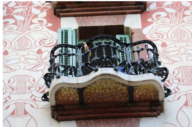
Imatge 23 (Foto IBN). Casa Rubinat, carrer de l'Or, 44. Projecte signat per Joan Rubió i Bellver, 1909. A sobre, detall del treball de forja i el trencadís dels balcons.
