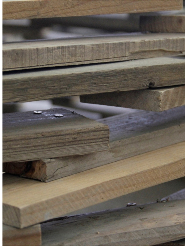
Fig. 5 Detall de les unions amb dos cargols al- ternant un mòdul a sobre i un a sota.
