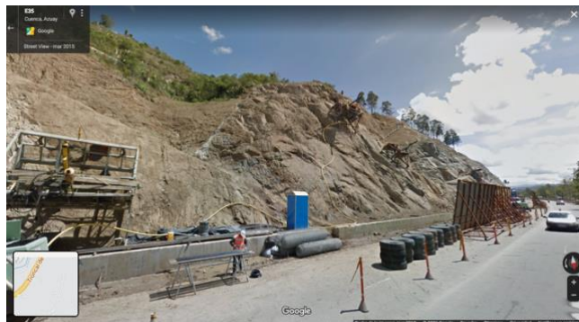
Imagen 5. Estabilización de taludes con hormigón proyectado en la Vía rápida Azogues - Cuenca.
