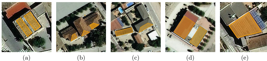
Figura 8.1: Fotografies aèries dels diferents edificis estudiats: (8.1a) ajuntament; (8.1b) casa de cultura; (8.1c) escola; (8.1d) centre cívic i (8.1e) llar d'infants. S'ha remarcat la coberta útil disponible per instal·lar panells fotovoltaics.
