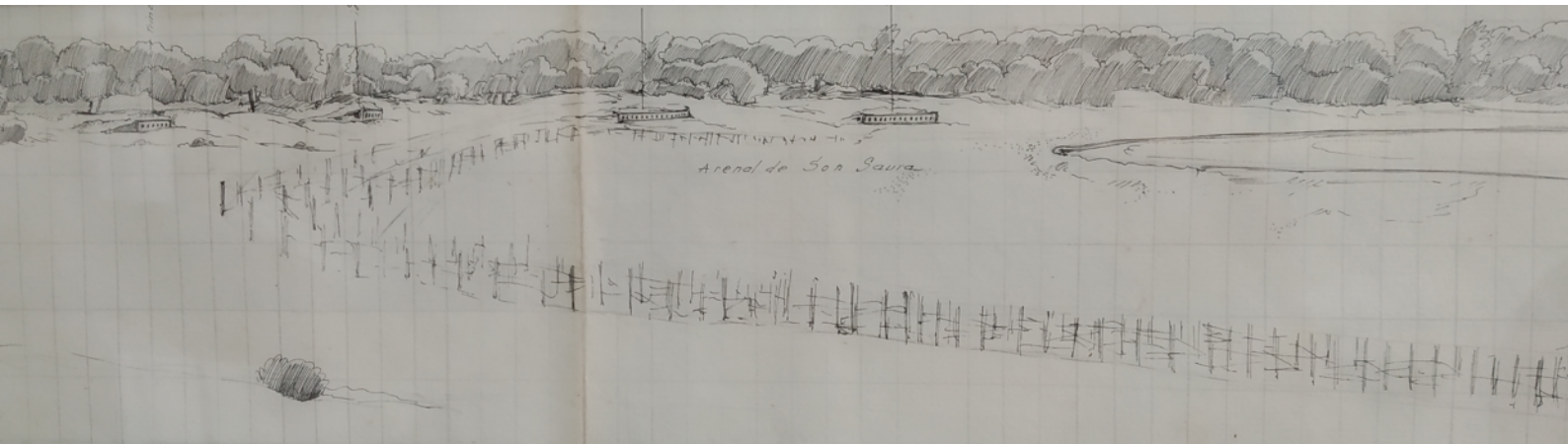
Il·lustració 17. Croquis de les defenses costaneres de l'arenal de Son Saura (Ciutadella) a principis del 1937, que mostra la col·locació del filferro a mode de barrera. A Son Bou hauria tingut un aspecte similar. Font: Museu Històric-Militar de Menorca.
