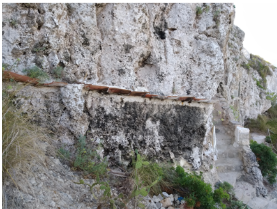
Canal de recollida de l'aigua de la pluja, que un temps conduïa l'aigua a una cisterna. Font: Fotografia pròpia, agost 2020.
