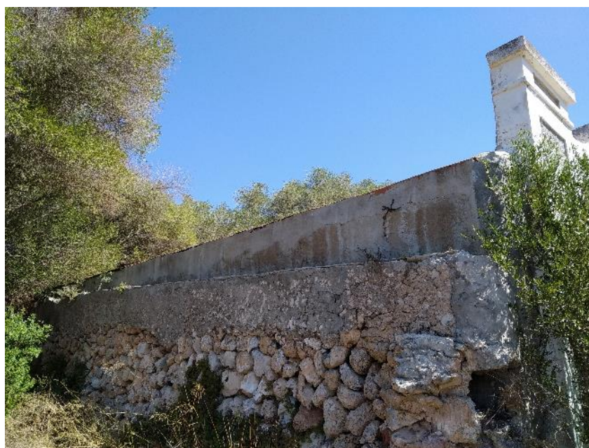
Paret lateral amb doble paret com a contrafort. Font: Fotografia pròpia, agost 2020.
