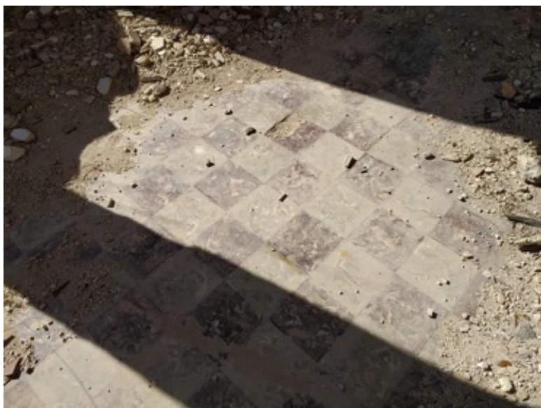
Terra de rajoles hidràuliques. Font: Fotografia pròpia, agost 2020.
