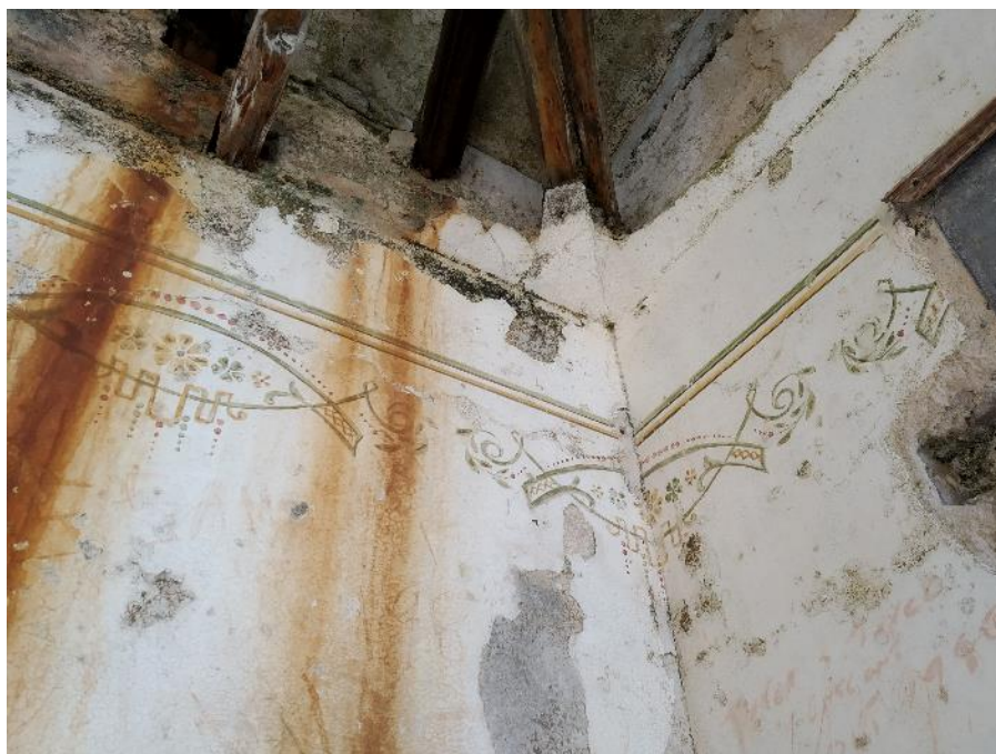
Esgrafiats a la part superior de les parets interiors. Font: Fotografia pròpia, agost 2020.
