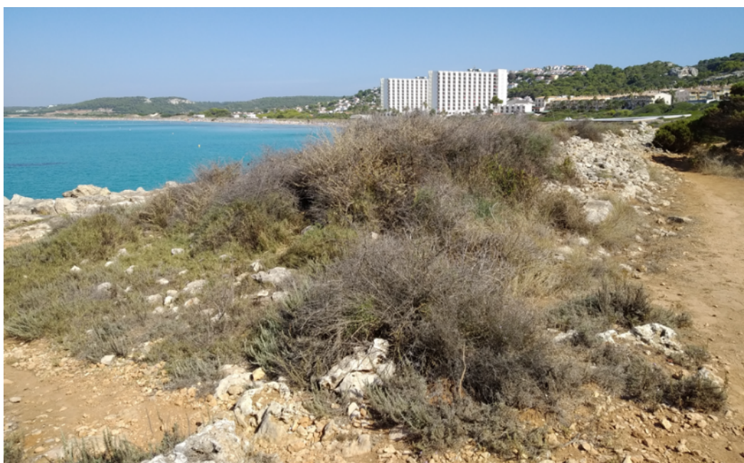
Vegetació que creix damunt el parapet. Font: Fotografia pròpia, agost 2020.
