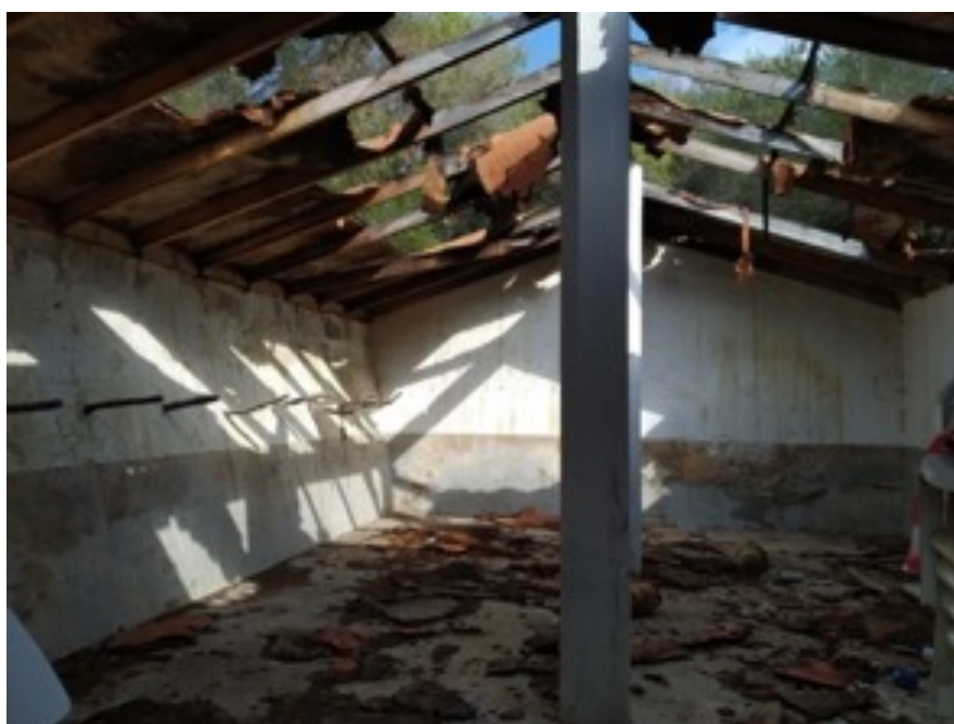
Interior de la Plana Major. Font: Fotografia pròpia, agost 2020.
