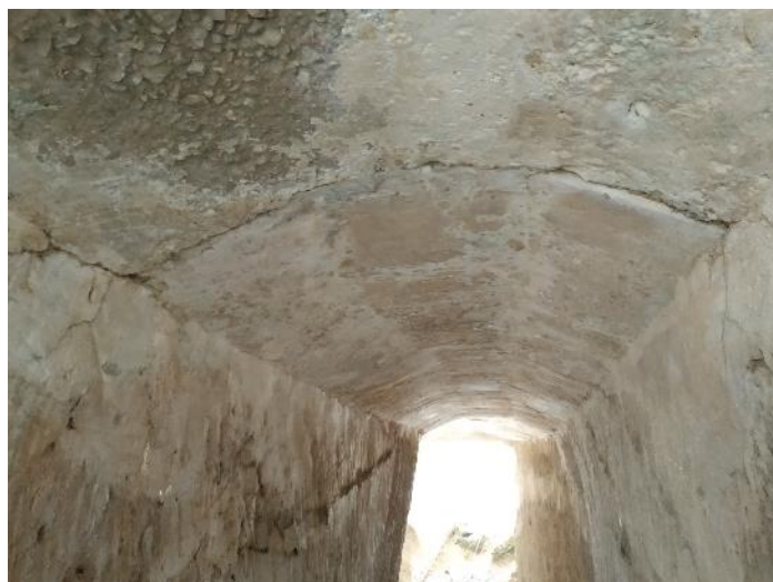
Sostre de blocs en un dels passadissos cegats. Font: Fotografia pròpia, agost 2020.
