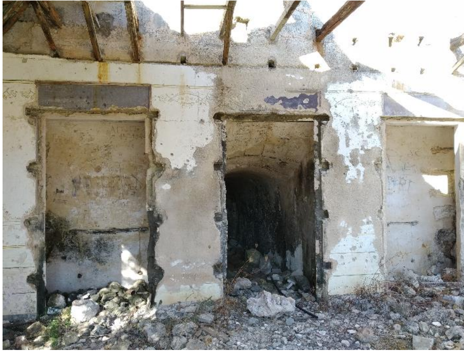
Paret del fons, amb dos armaris encastrats i un refugi. Font: Fotografia pròpia, agost 2020
