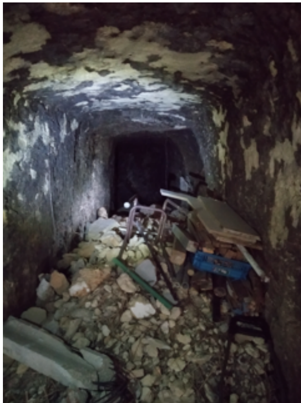
Estat de l'interior. Font: Fotografia pròpia, agost 2020.
