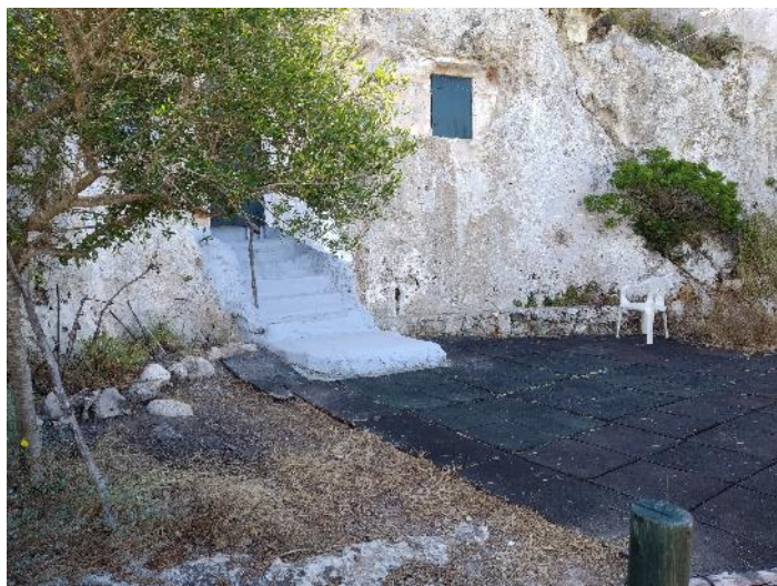
Façana i terrassa. Font: Fotografia pròpia, agost 2020.
