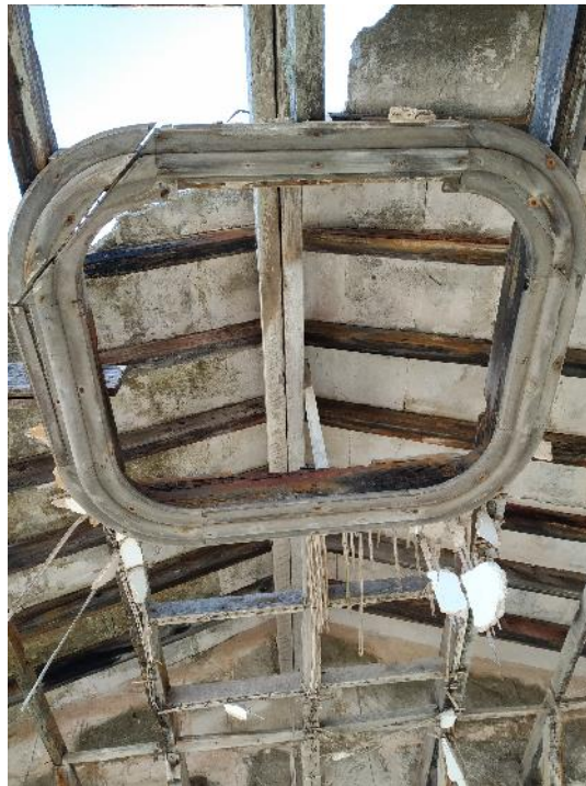
Sostre de bigues i obertura cap a la teulada. Font: Fotografia pròpia, agost 2020.
