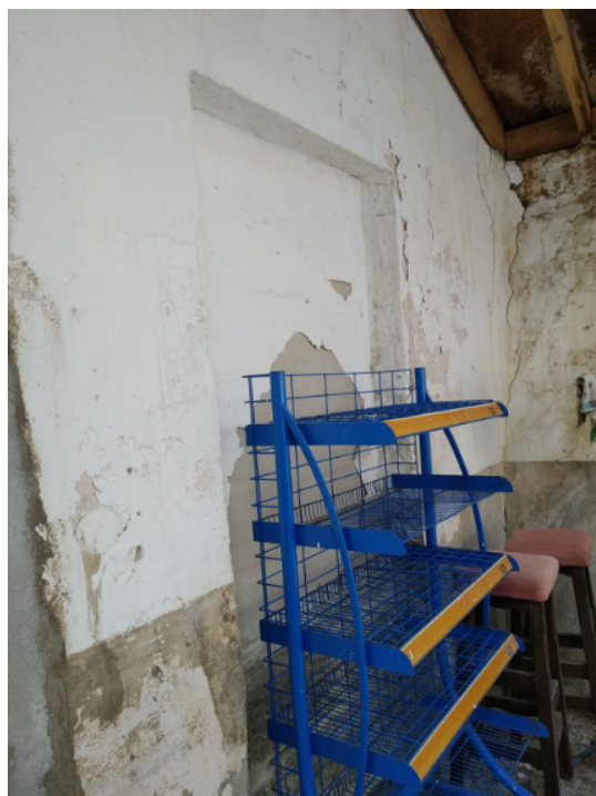
Interior de la Plana Major. Finestra tapiada. Font: Fotografia pròpia, agost 2020.
