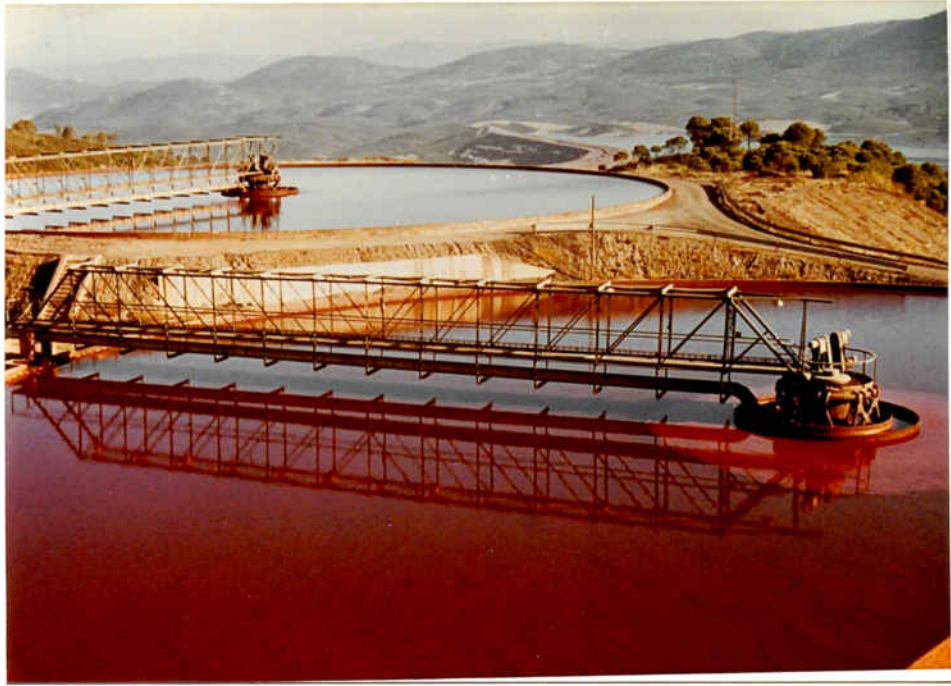
Figura 7 - Decantadores de la pulpa cianurada
