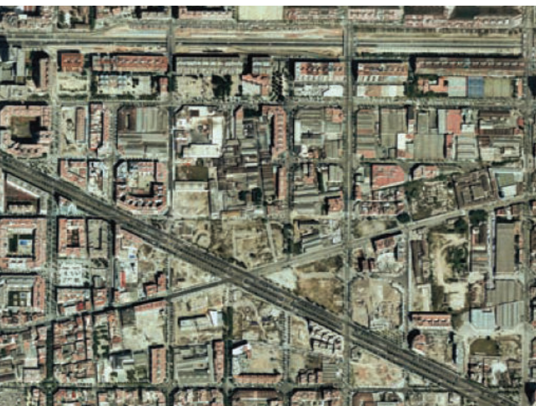
Figura 2.04: Ortofoto del área de Avenida Diagonal a su paso por el Poblenou 2005.
