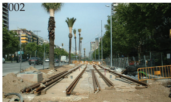
Figura 4.10: Foto, obras Trambaix sobre Av. Diagonal.
