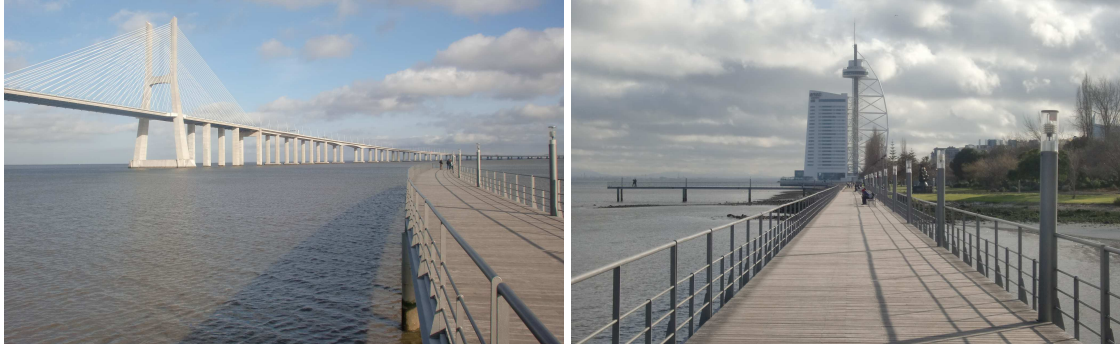
1) Pont Vasco de Gama i passarel·les sobre el riu Tajo. 5
