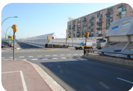
Fig.3.1.13 Foto Pasarelas Peatonales.
