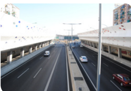
Fig.3.1.6 Foto Área Verde. Fig.3.1.7 Foto Área de Juegos Infantiles. Fig.3.1.8 Foto Área de Descanso. Fig.3.1.9 Foto Elementos Estéticos. Fig.3.1.10 Área de Circulación. Fig.3.1.11 Áreas para la Movilidad.
