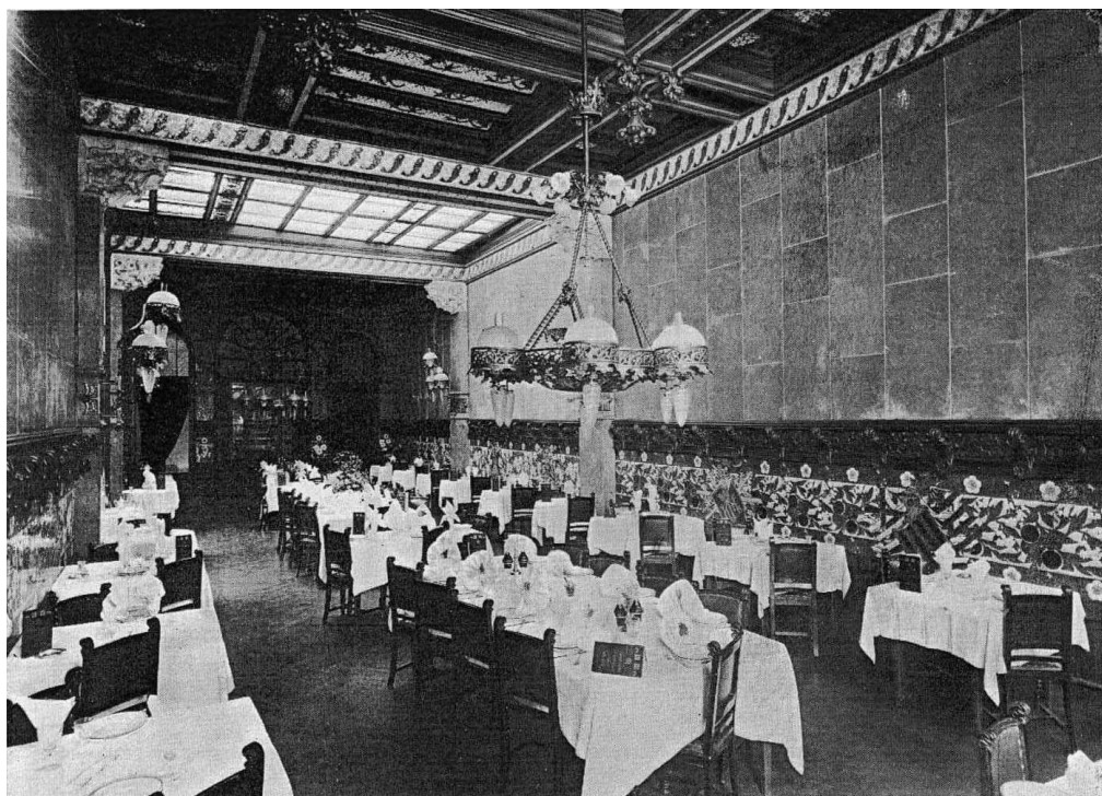
Fig.204. Saló menjador de la Fonda de España , c.1900. ( Arquitectura y Construcción , 01-1904, núm. 138, p. 19).
