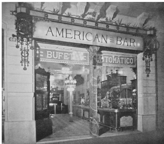
Fig.191. Façana de l' American Bar , 1912. ( Arquitectura y Construcción , 12-1912, núm. 245, p. 363).
