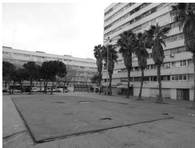
Imagen 142: Deterioro espacio público Mina Vella. Fuente: Propia, 2016.
