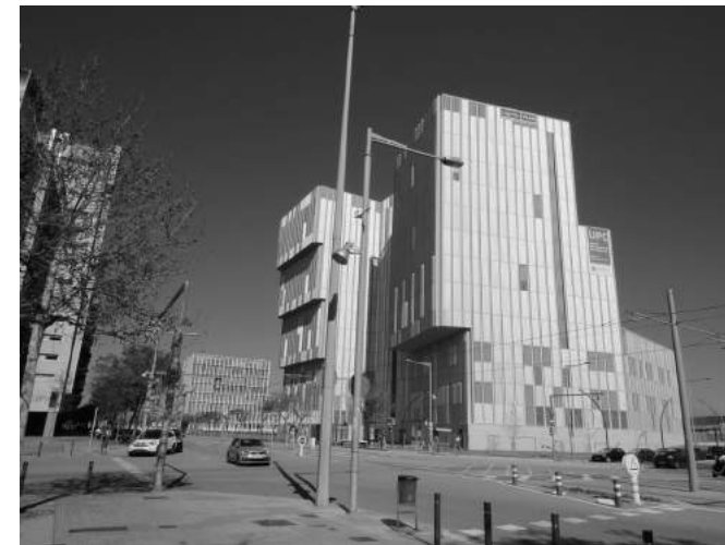
Imagen 135: Campus universitario en construcción. Fuente: Propia, 2016.
