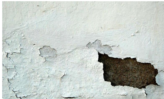
Figura 7 - Un dels principals problemes de no respectar els temps d'assecatge és l'aparició prematura de butllofes que provoquen el despeniment i pèrdua de les pintures i els revestiments. © Sergio Sánchez
